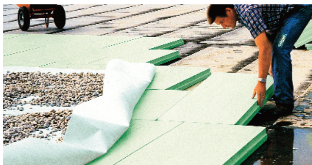
8 Żwir wysypuje się na geowłókninę, zabezpieczającą niższe warstwy przed zanieczyszczeniami, które mogą przedostawać się z warstwy wierzchniej
