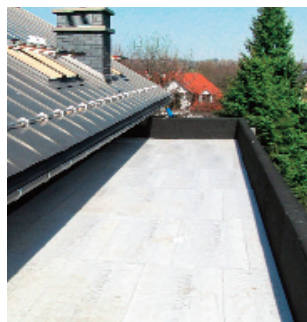
2 Izolacja termiczna z polistyrenu ekstrudowanego
