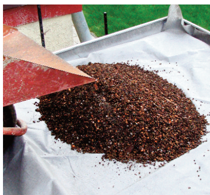
5 Przygotowanie podłoża pod rośliny – substrat ułożony na geowłókninie nie zamuli drenażu
