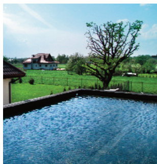
1 Próba szczelności izolacji przeciwwilgociowej
