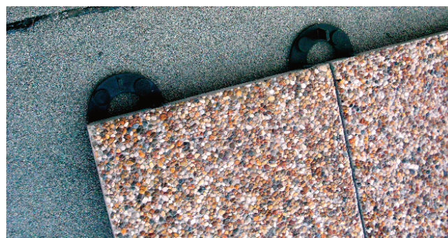
9 Betonowe płyty chodnikowe ułożone na podstawkach ułatwią korzystanie z tarasu na dachu płaskim
