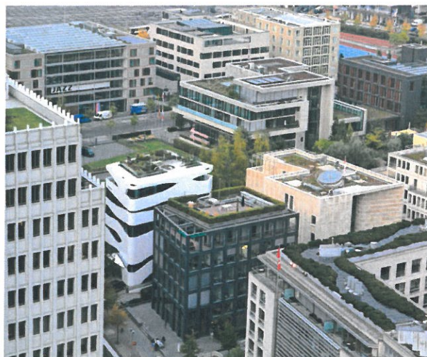
FOT. 1. Dachy zielone przy placu Poczdamskim w Berlinie; fot.: APK Dachy Zielone
